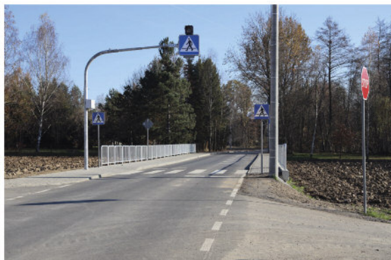
Przebudowa drogi gminnej Stadniki-Kwapinka w Kędzierzynie (etap III)
