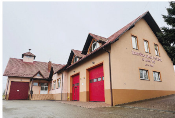
Modernizacja budynku OSP w Nowej Wsi m.in. modernizacja łazienek
