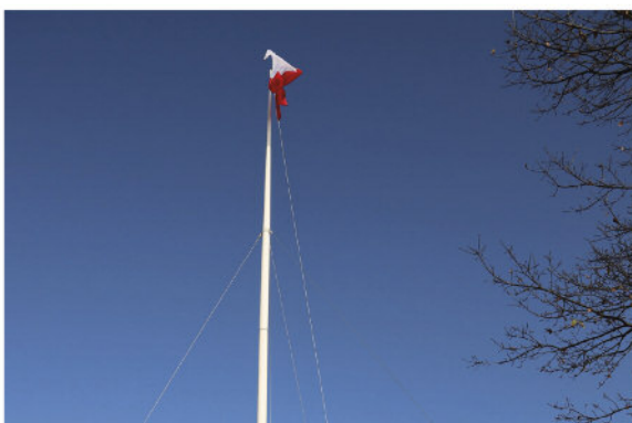
Budowa masztu flagowego na wzgórzu zamkowym
