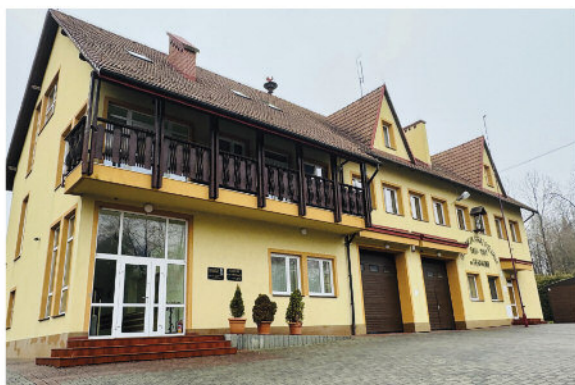
Montaż monitoringu w OSP Sieraków
