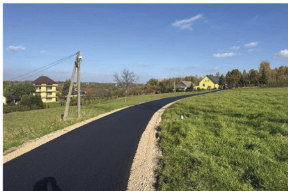
Modernizacja drogi nr 13 w Stojowicach
