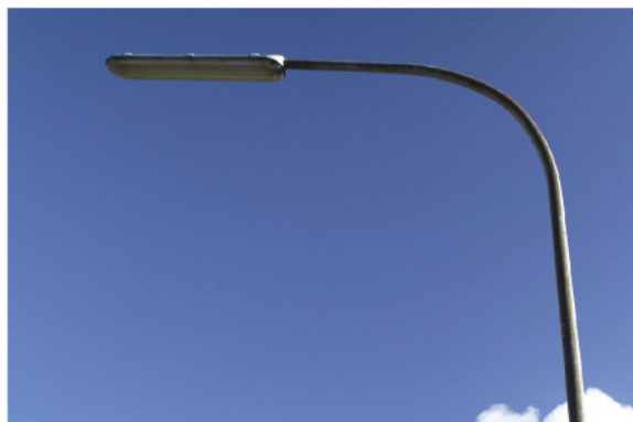
Wymiana opraw oświetleniowych na ledowe
