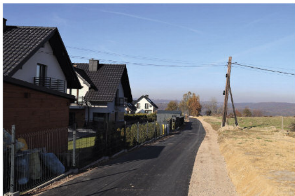
Modernizacja drogi na dz. nr 1 w Skrzynce
