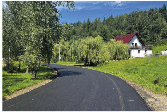
Modernizacja drogi Dziekanowice - Grajów
