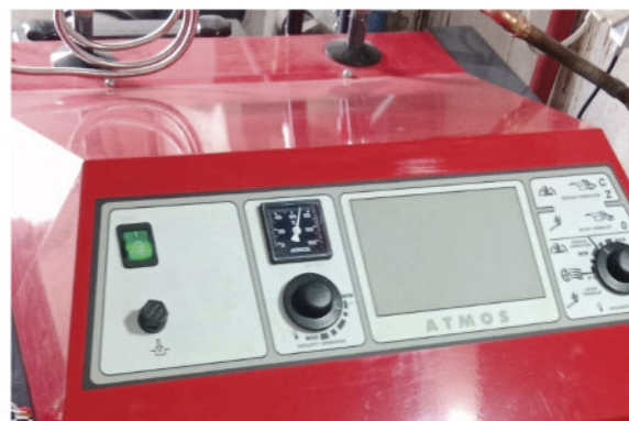
Dofinansowanie modernizacji systemów ogrzewania w budynkach
