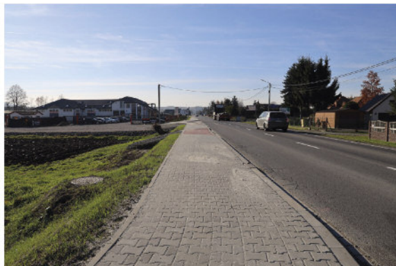
Budowa brakującego fragmentu chodnika na ul. Zarabie
