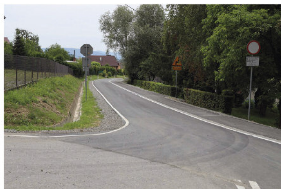
Budowa ścieżki rowerowej w Stojowicach za strażnicą
