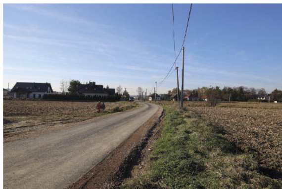
Modernizacja drogi do Kurnika etap I w Niezdowie
