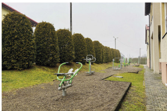
Montaż urządzeń siłowni plenerowej przy SP Brzączowice
