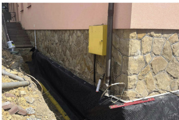
Wykonanie odwodnienia budynku Szkoły Podstawowej w Nowej Wsi
