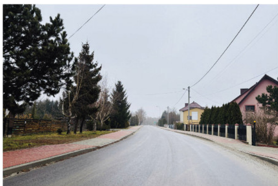
Przebudowa drogi powiatowej ul. Jagiellońska - dofinansowanie zadania Powiatu Myślenickiego
