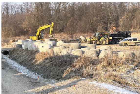
Budowa kanalizacji sanitarnej ul. Laskowa
