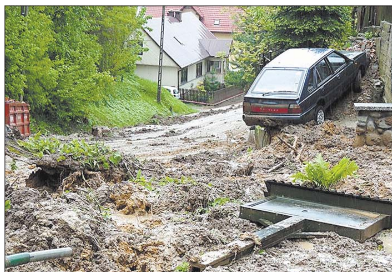
Schlammmassen haben sich nach den unwetterartigen Regenfällen ihren Weg auf Dobczyces Straßen gesucht. Autos sind dabei gegen Mauern und Häuser gerutscht.
